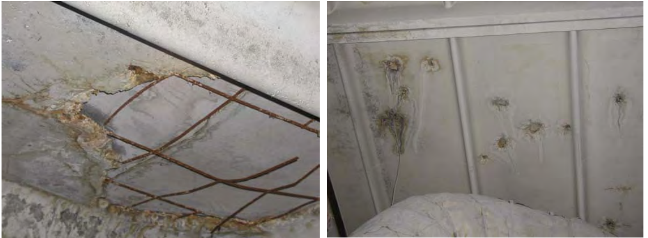
Рис.1. Следы выщелачивания бетона на конструкциях подвального перекрытия цеха корпуса Р-1 ОАО «ВОЛТАЙР-ПРОМ» 2005г.
