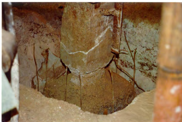
Рис.5. Разрушение тела бетона несущей колонны (CRYOVAC ЗАО Силд Эйр-Каустик», 2002г.).
