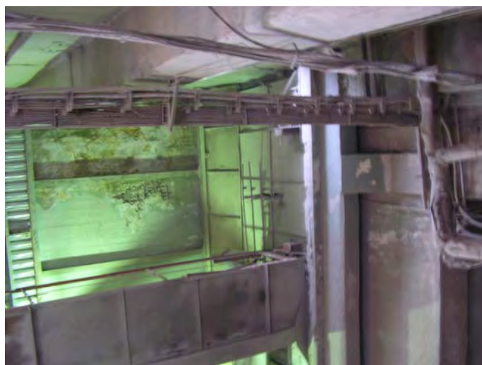
Рис.3. На потолке видны бурые следы коррозионного процесса (ОАО «Себряковцемент», 2009г.)
