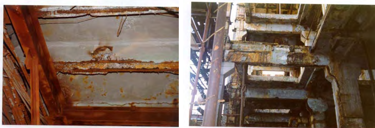
Рис.4. В следствие коррозии II вида обнажилась арматура и произошло отслоение защитного слоя бетона (CRYOVAC ЗАО Силд Эйр-Каустик», 2002г.)
