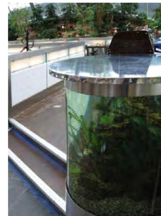
Аквариум является частью барной стойки. Доступ осуществляется путем снятия верхней столешницы, выполненной из легкого металла. Выполнен из силикатного стекла, гнутого по малому радиусу, в результате он имеет всего два шва (по задней стенке). Ресторан «Киваяки» в мебельном центре «Гранд-2».
