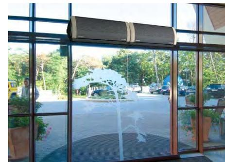
Использование высокопроизводительных тепловых завес для защиты постоянно открытого проема
