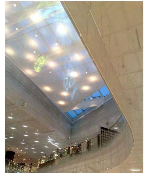
Экранированные светильники дают рассеянный свет в атриумном пространстве, кроме того, тканевый экран не пропускает прямой солнечный свет в дневное время суток
