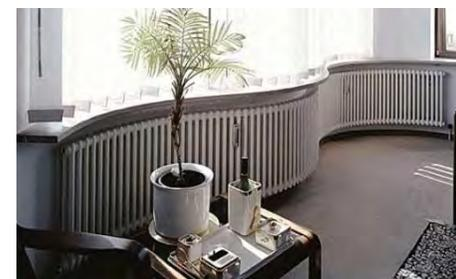
Возможно изготовление изогнутого радиатора
