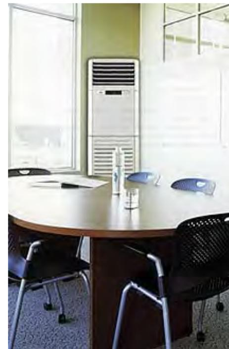
Колонные кондиционеры незаменимы при невозможности размещения внешних блоков на фасадах здания
