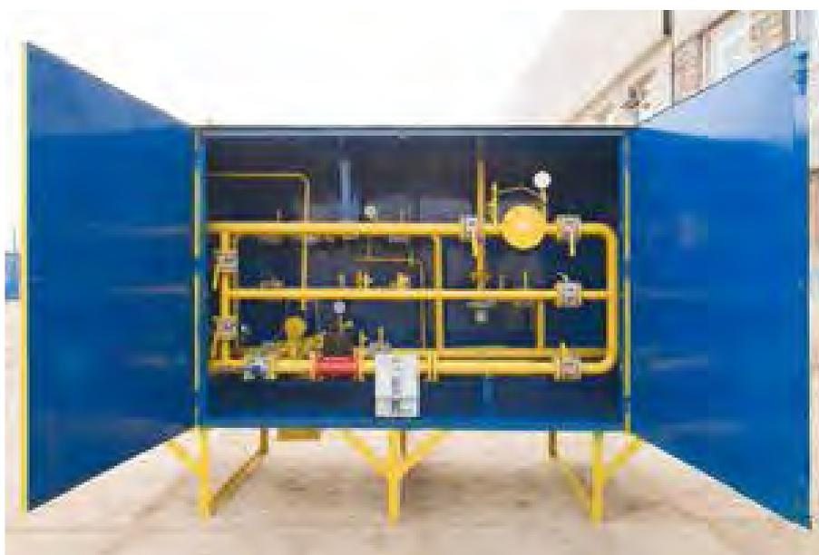
Рисунок 1 – Современный шкафной газорегуляторный пункт
