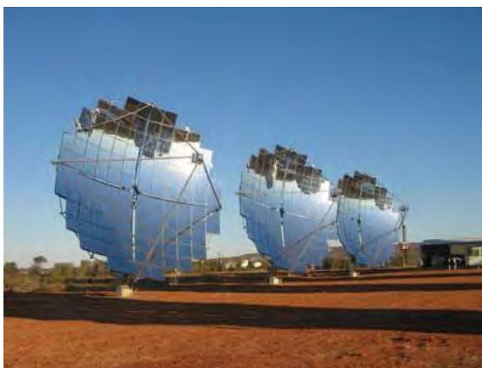
Другим типом СЭС, получившим развитие, стали установки с двигателем Стирлинга, размещаемым в фокусе параболического зеркального концентратора. КПД таких установок "может достигать 29%.
