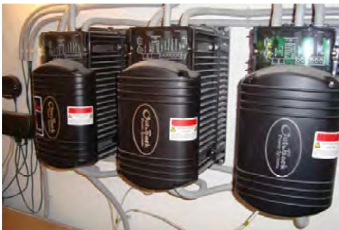
Рисунок 4 – Преобразователь постоянного тока
