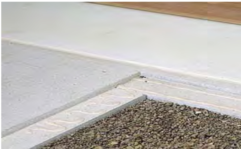
Рис. 9.1. Конструкция сборного сухого пола, где сухая стяжка уложена на слой керамзита [36]
