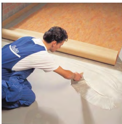
Рис. 6.1. Нанесение грунтовки перед настилкой линолеума [26]
