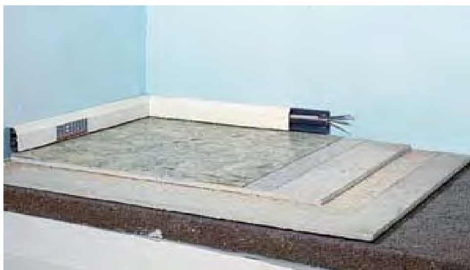
Рис. 9.2. Конструкция сборного сухого пола, где сухая стяжка уложена на слой вспененного материала — пенополистирола [34]
