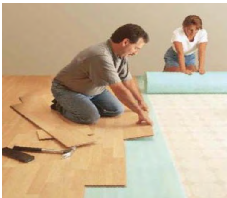
Рис. 8.3. Бесклеевой способ укладки ламинированного паркета [33]
