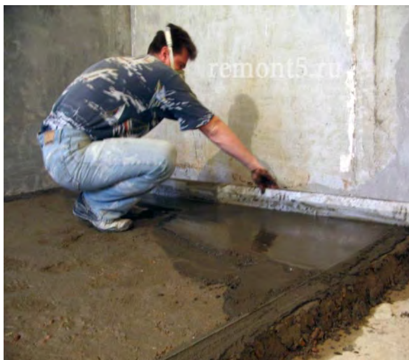
Рис. 8.2. Устройство стяжки для полов из ламината [31]
