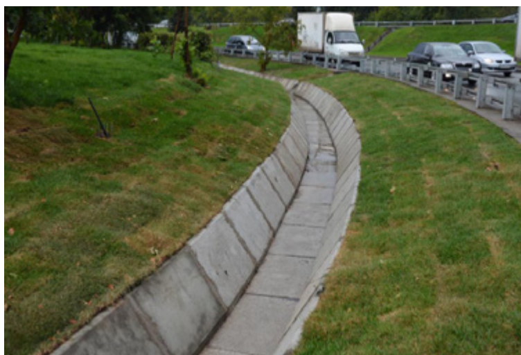
Рис. 4. Укрепление канав бетонными плитами
