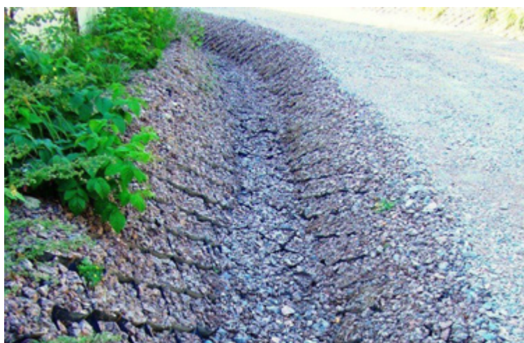
Рис. 3. Укрепление канав щебнем
