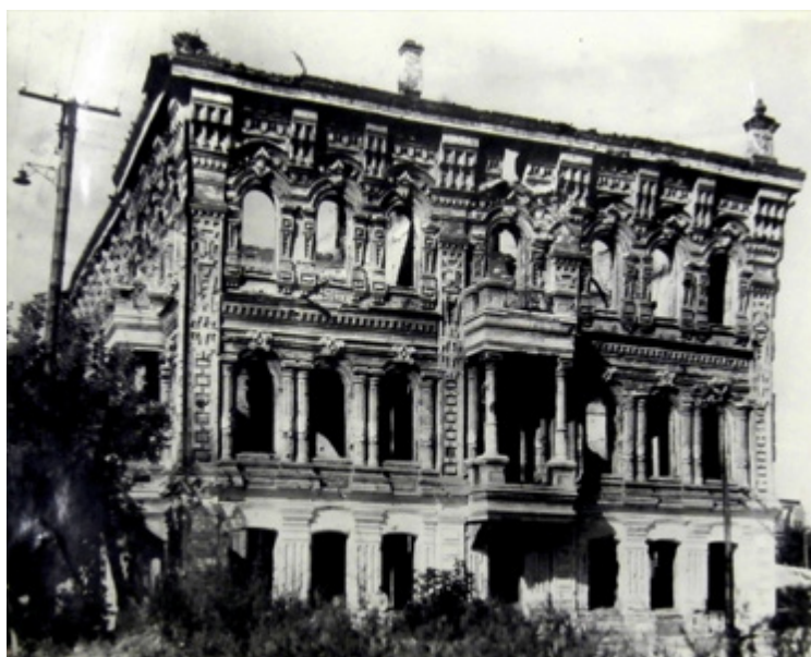
Рис. 9. Областной земельный отдел (быв. дом Божескова) после Сталинградской битвы. Фасад со стороны ул. Воровского (Спасской) [13]: публикуется впервые
