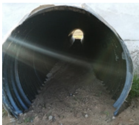
Рис. 5. Заиливание отверстия трубы
