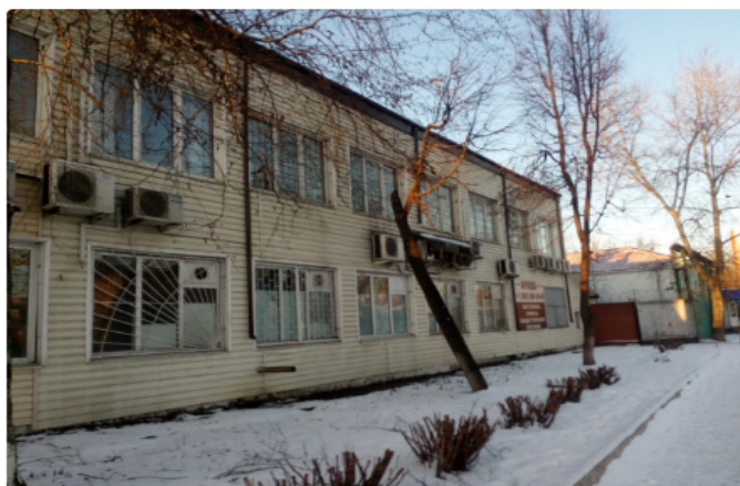
Рис. 5. Административное здание с производственными помещениями
