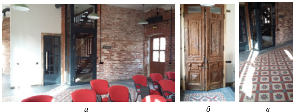
Рис. 8. Интерьеры «Лофт 1890»: а — лекционный зал; б — двери; в — восстановленные элементы интерьера. Рисунок на плитке воссоздан по рисунку на остатках плитки, найденной во время работ по гидроизоляции фундамента. Фото Г. А. Птичниковой
