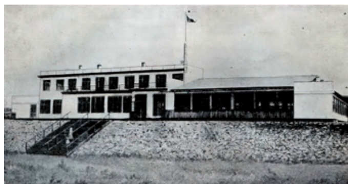
Рис. 3. Пассажирское здание в Кременчуге
