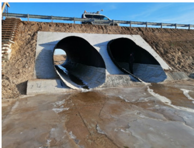
Рис. 3. Переход через балку Черная, МГТ 2×3,0
