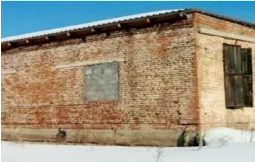
Рис. 6. Здание холодных кладовых
