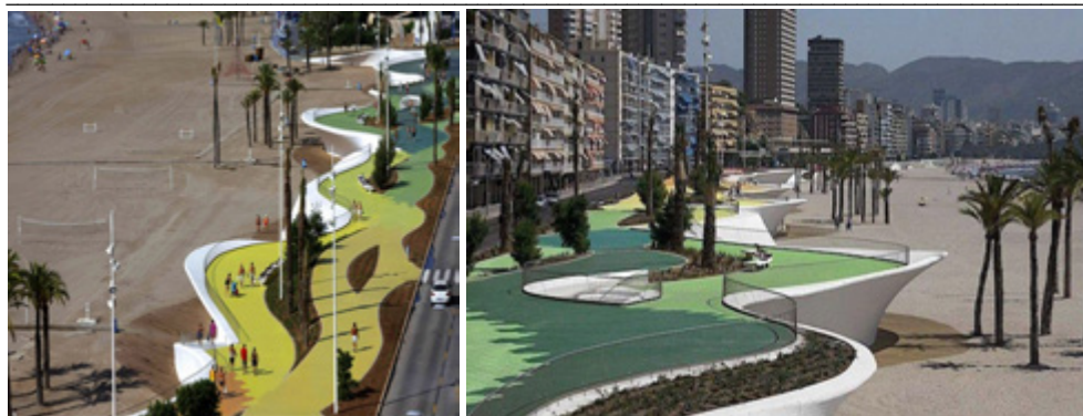
Рис. 4. Благоустройство набережной Platja de Ponent, Бенидорм
