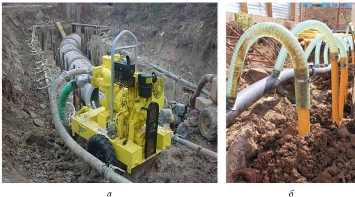
Рис. 4. Искусственное понижение грунтовых вод: *а* — насос для откачки воды и иглофильтры; *б* — всасывающий коллектор
