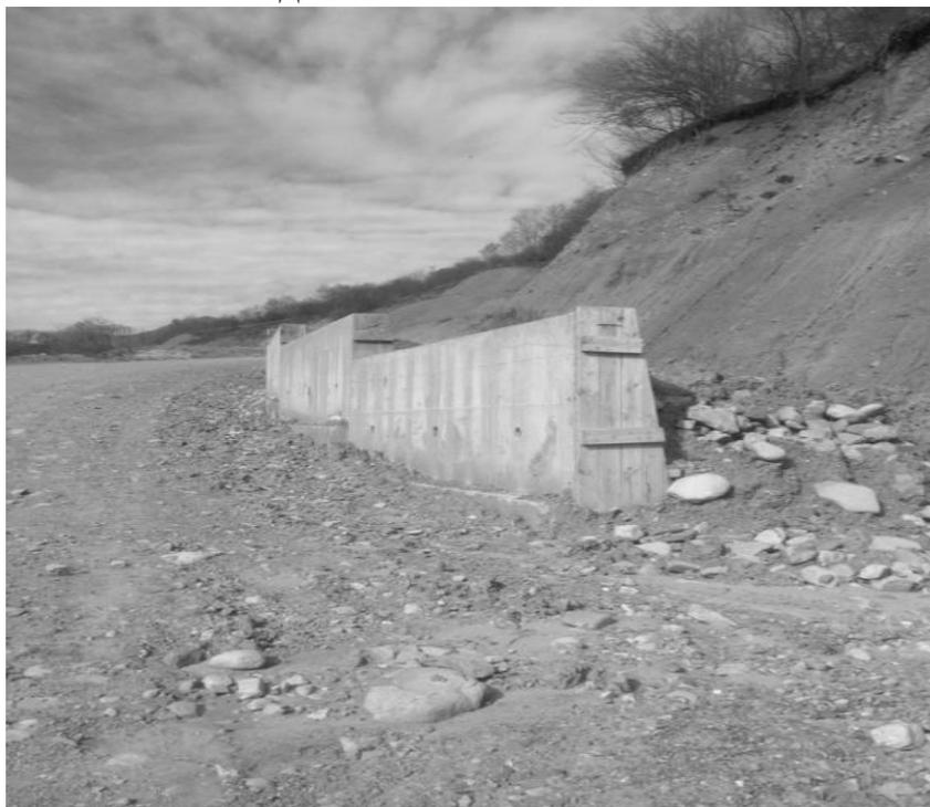
Рис. 2. Подпорные стены на скальных выемках, построение без соответствующего анализа надобности их строительства
