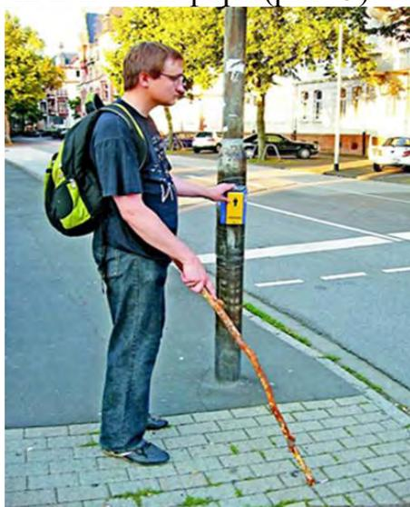
Рис.5. Светофор с кнопкой, которая вибрирует на зеленый свет
