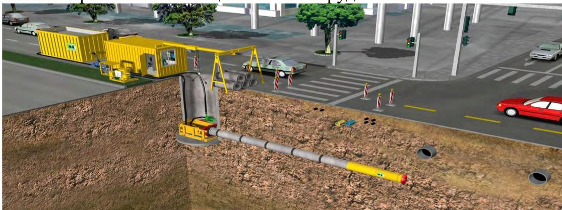
Рис. 1 Пример работы бестраншейной установки без остановки движения на проезжей части
