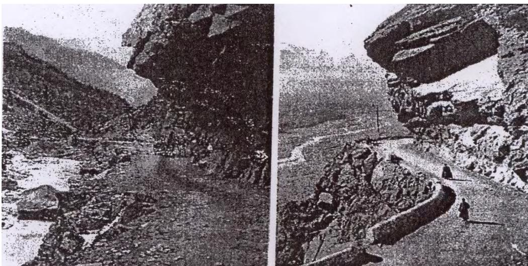
Рис. 2. Участки дорог с нависающим верховым откосом и обрывом на нижнем склоне:
