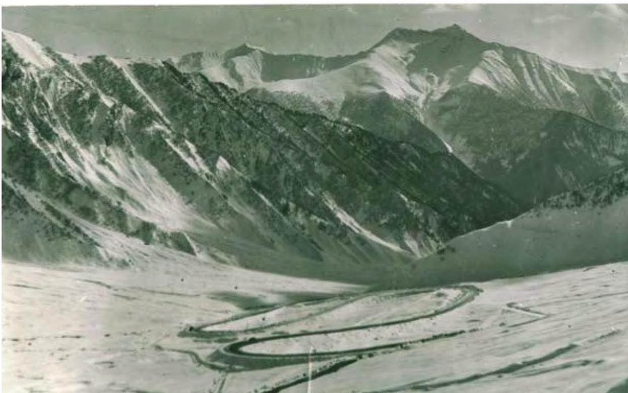
Рис. 3. Участок Транскама (32-ой км.) с максимальным уклоном  $80\text{‰}$ , минимальным радиусом на кривой (50 метров) и максимальным количеством ЧП.
