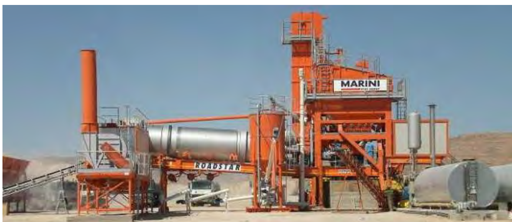
Рис.1. Общий вид асфальтобетонного завода MARINI ООО «Радель»
