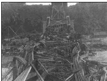
Рис.3 Первая катастрофа на мосту через р. Святого Лаврентия в Квебеке
