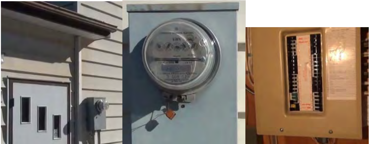
Рис. 3. Счетчик учета электроэнергии и распределительный щиток
