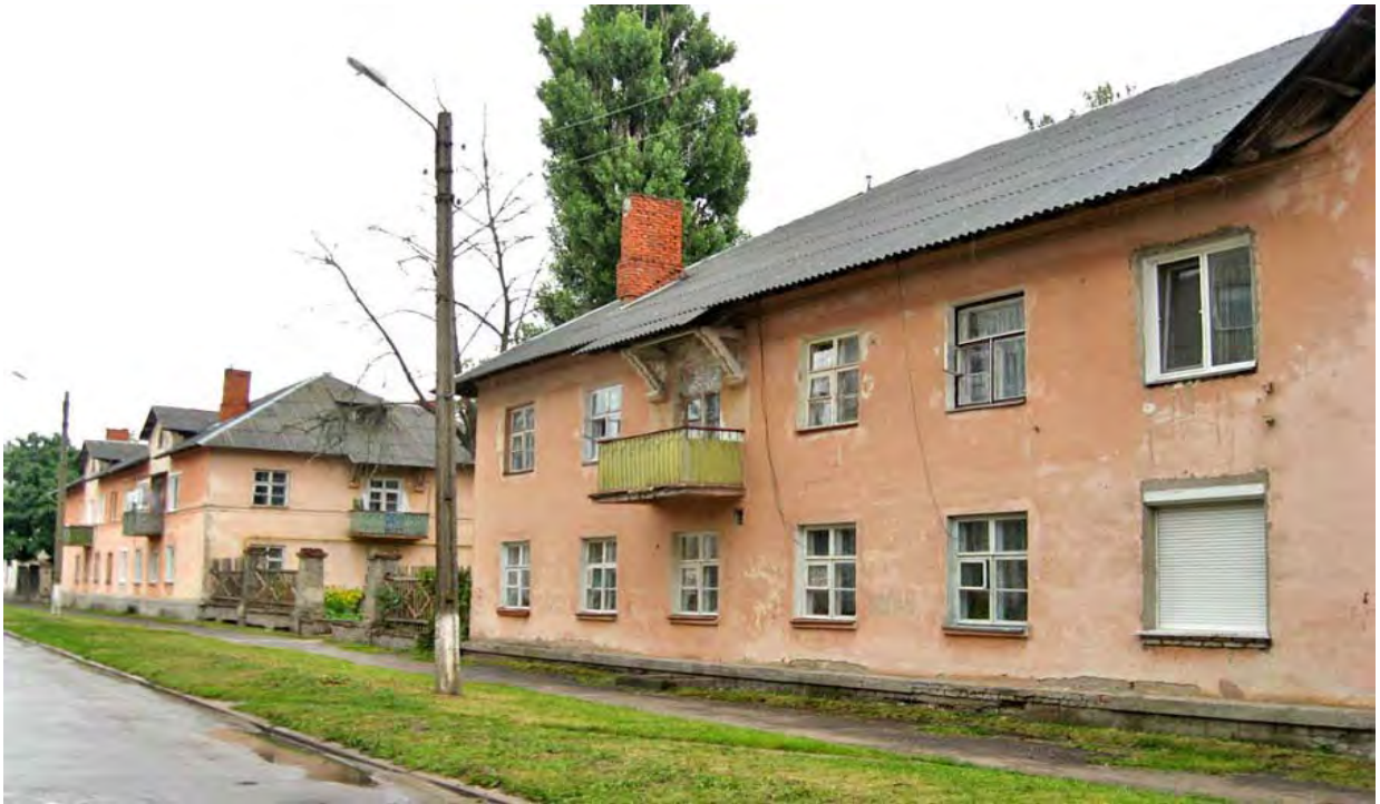
Рис.3 Двухэтажный жилой дом, требующий капитального ремонта Так как же решить жилищные проблемы россиян?
