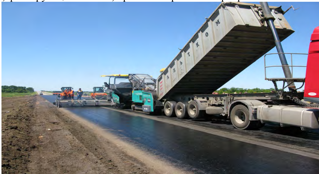
Рис.2-Автомобильная дорога Ашхабад - Туркменбаши во время стройки
