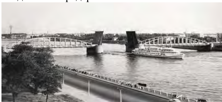
Рис. 1. Мост через Неву с арками из многотрубного трубобетона.
