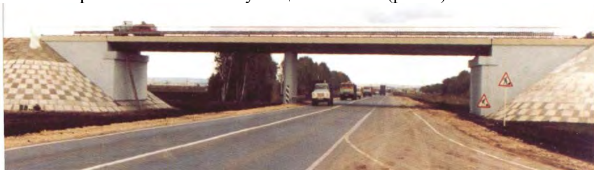
Рис.1. Двухпролётный железобетонный путепровод.
