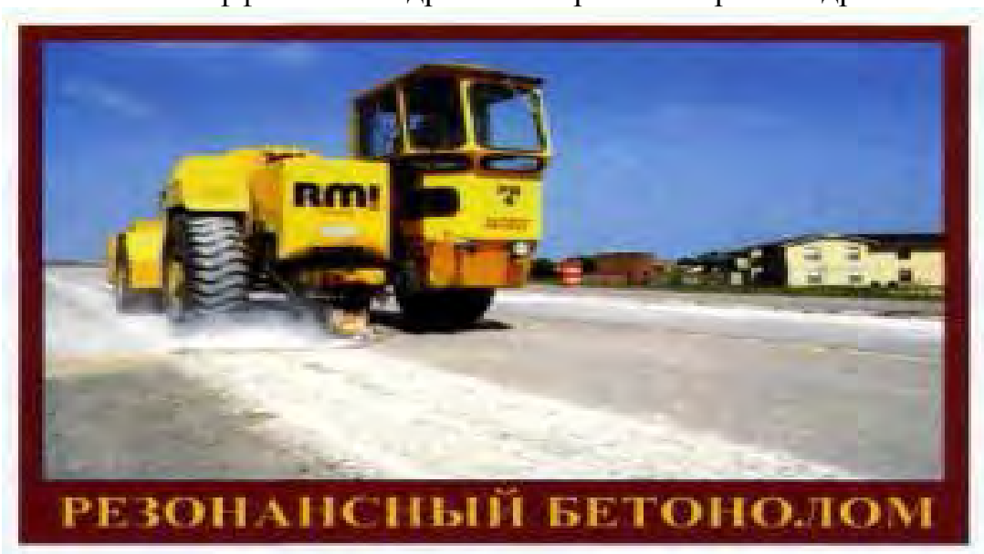
Вариант 1. Разрушение бетонного покрытия.
