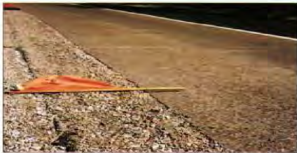
Вариант 2. Разрушение асфальтобетонного покрытия.
