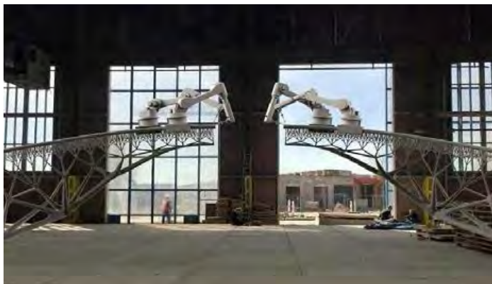
Рис. 1. Создание арочного моста с помощью 3D принтера
