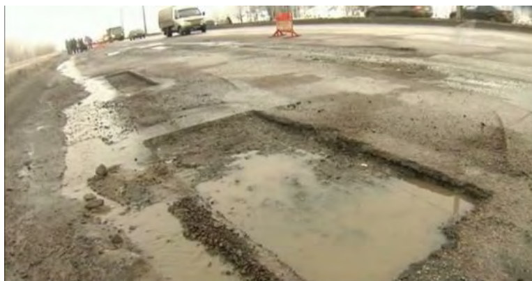
Рис.2. Фрезерование проезжей части при ремонте 1-ой продольной магистрали
