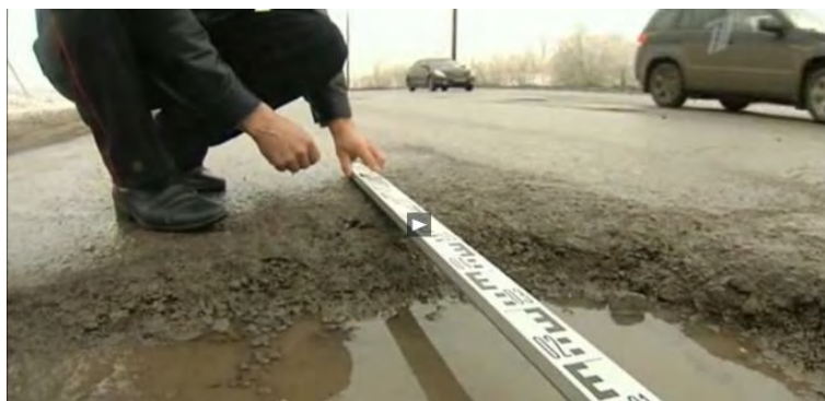
Рис.1. Разрушения проезжей части 1-ой продольной магистрали
