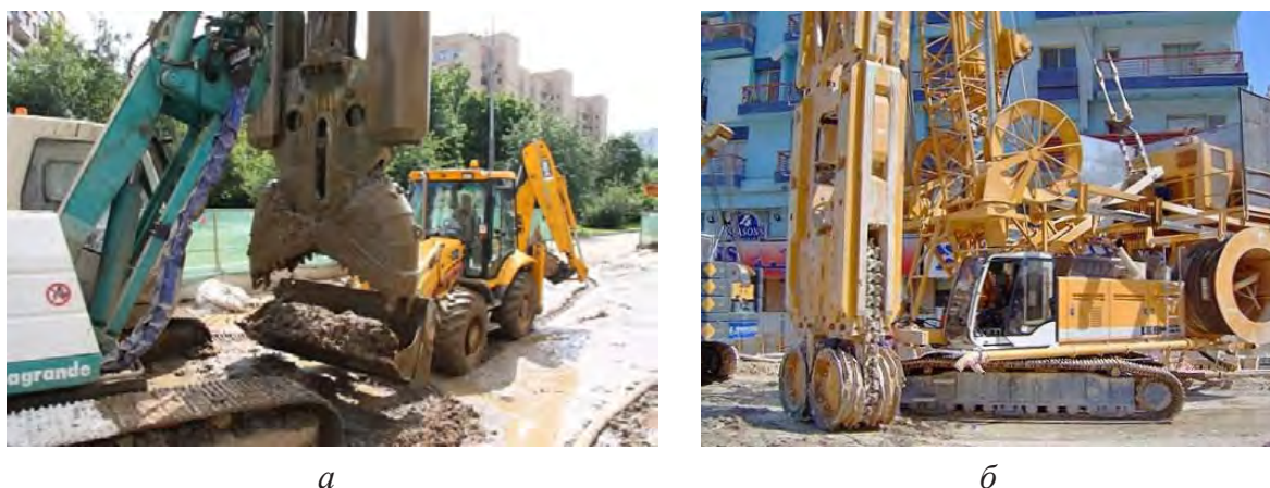
Рис. 5.25. Технологическое оборудование для разработки траншей с вертикальными стенками: а — с помощью грейфера; б — с помощью гидрофрезера
