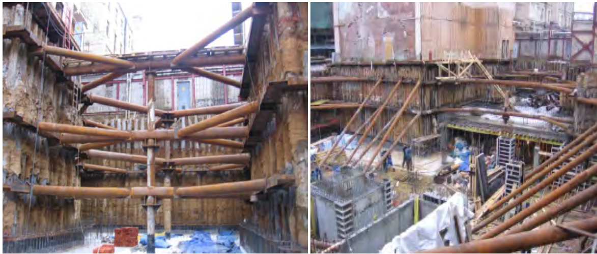
Рис. 5.15. Крепление распределительных поясов ограждающей конструкции котлована: а — трехъярусное горизонтально-рамное; б — наклонно-подкосное
