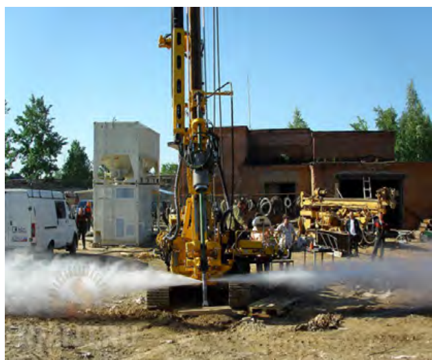
Рис. 5.7. Технологическое оборудование для устройства грунтоцементных свай способом струйной цементации (Jet-grouting): а — буровая установка; б — монитор, оснащенный соплами
