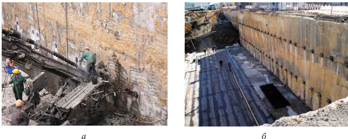
Рис. 5.26. Технология устройства 2-ярусной «стены в грунте»: а — бурение анкерных скважин с установкой обсадных труб; б — «стена в грунте» с бетонными анкерами
