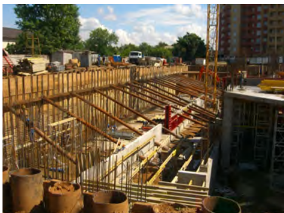
Рис. 5.16. Ограждение котлована из стальных элементов с забиркой:
