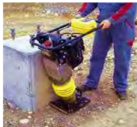
Рис. 5.4. Средства малой механизации: a — виброплита с поступательным движением; б — вибротрамбовка
