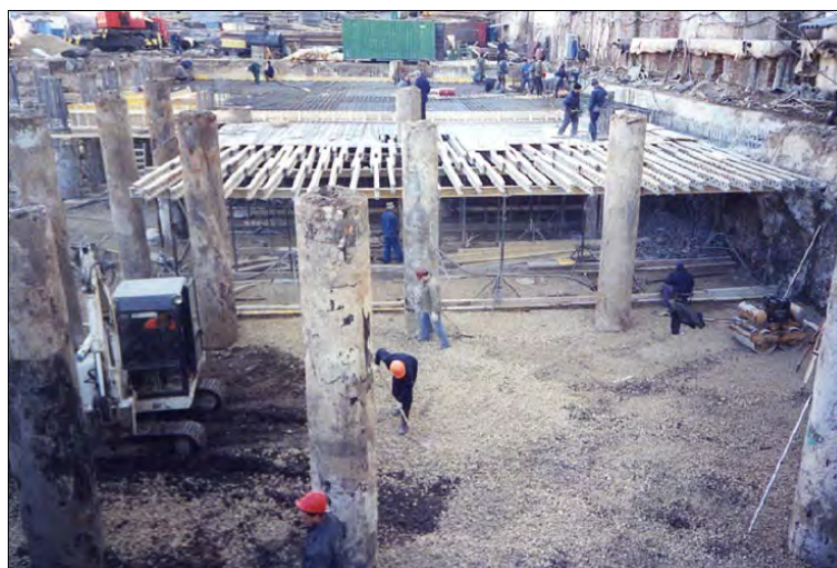
Рис. 5.28. Устройство инвентарной опалубки перекрытий, опирающейся на подготовленное грунтовое основание
