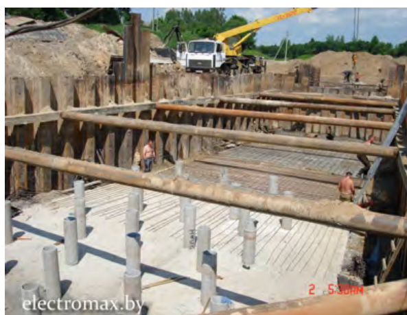
Рис. 5.19. Защита возводимых конструкций шпунтовой стенкой
