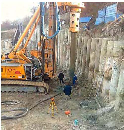
Рис. 5.23. Устройство «стен в грунте» из буронабивных свай
