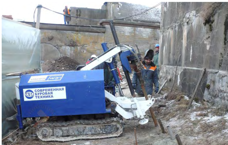
Рис. 5.8. Буровая установка для силикатизации грунта
