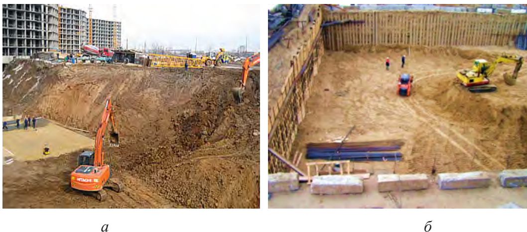
Рис. 5.10. Открытый котлован: а — без крепления боковых стенок; б — с креплением боковых стенок
