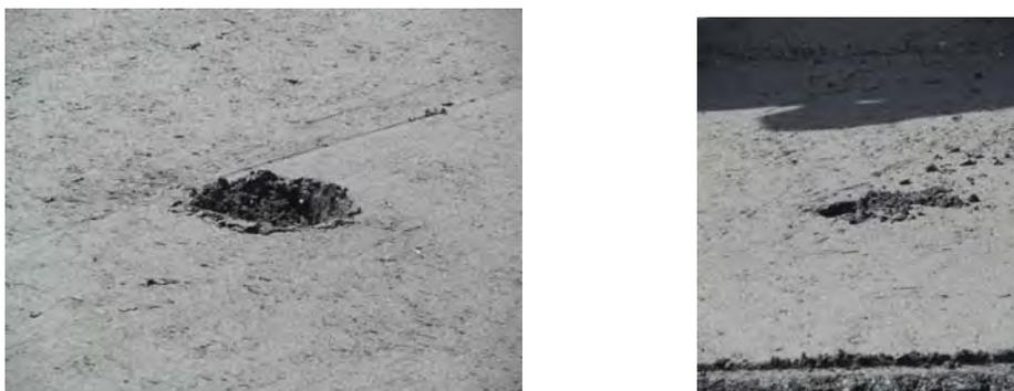
Рис. 5.14. «Проплешины» на поверхности свежеложенной асфальтобетонной смеси
