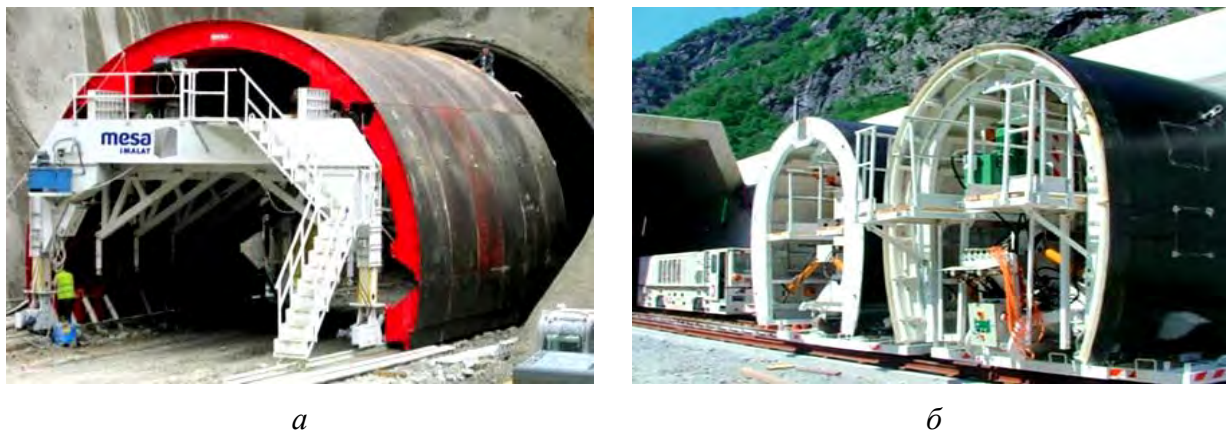
Рис. 1.7. Тоннельная опалубка: a — MESA IMALAT; б — OUTINOOR
