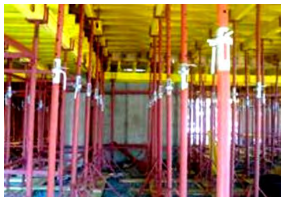
Рис. 1.12. Опалубка перекрытий на телескопических стойках
