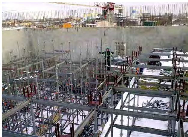
Рис. 1.15. Опалубка перекрытий на опорных лесах
