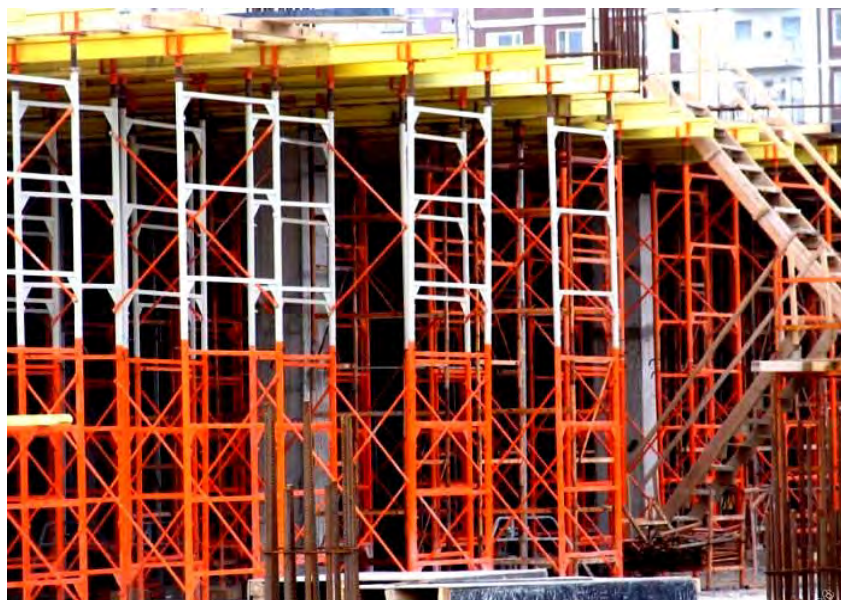
Рис. 1.16. Опалубка перекрытий на рамах
