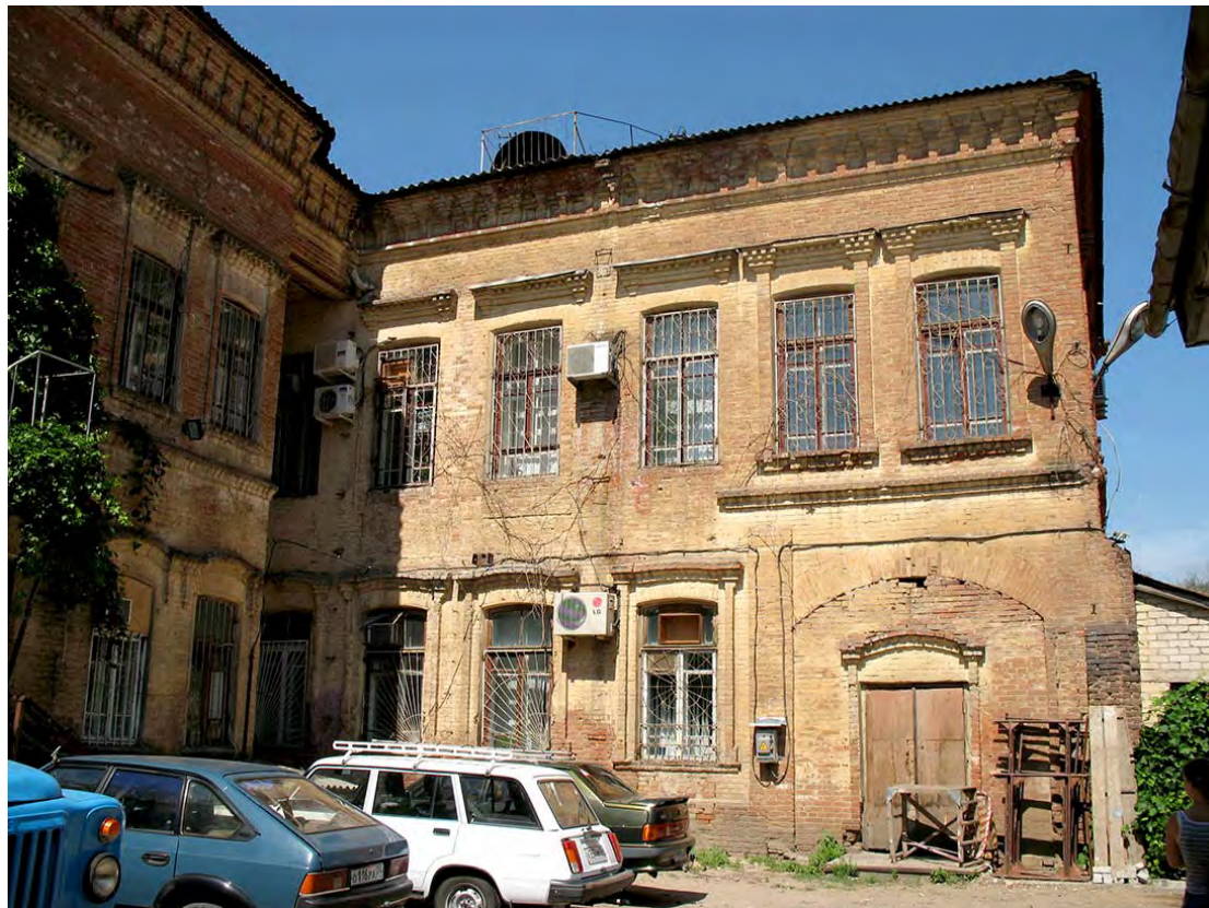
Рис.1. Примеры фотографий фасадов здания
