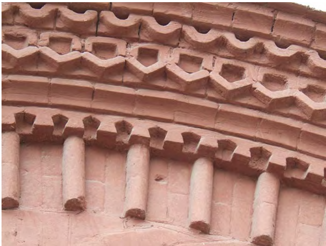
Рис. 2. Примеры выполнения фотографий деталей фасада
