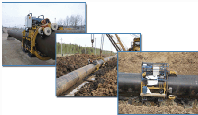
Рис. 7. Применение внешнетрубного дефектоскопа ДНС-1400 на участке газопровода, выведенного в ремонт
