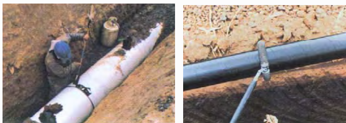
Рис. 19. Контроль сплошности покрытий с помощью холидей-детекторов
